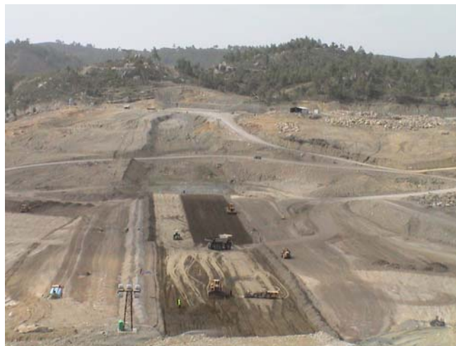
Εικόνα 1.6: Γενική άποψη φράγματος στο στάδιο κατασκευής (ΑΕΓΕΚ, 2002).
