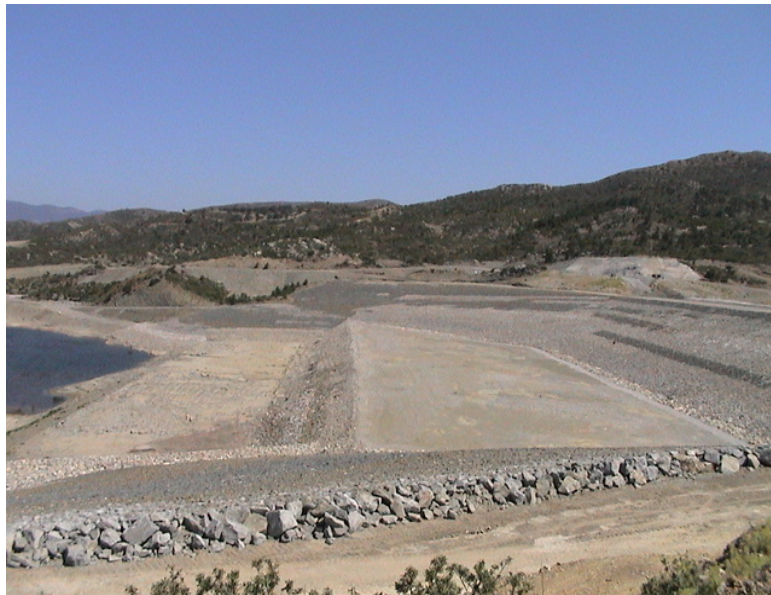
Εικόνα 1.4: Βοηθητικό – κύριο ανάντη πρόφραγμα.
