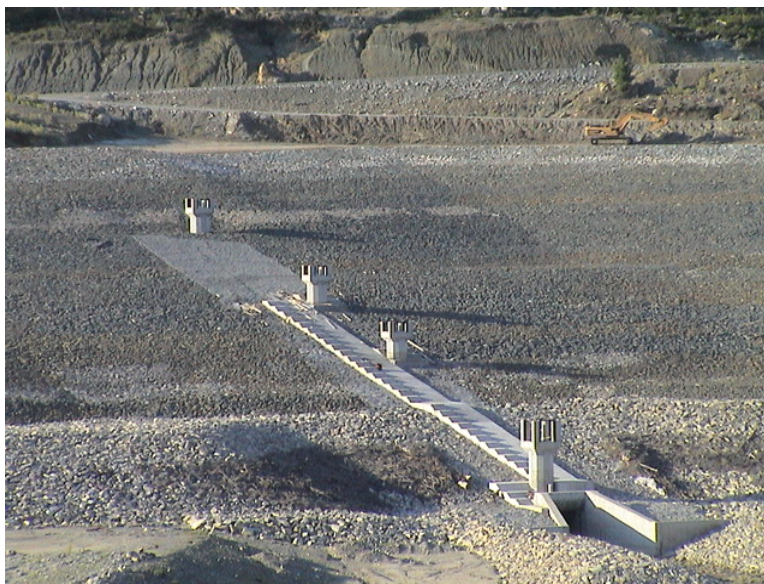
Εικόνα 1.3: Στόμιο εκκένωσης και υδροληψίες.
