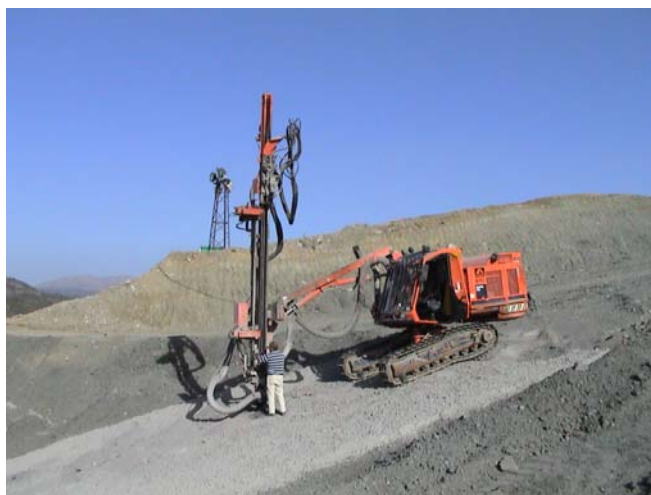
Εικόνα 1.5: Τσιμεντενέσεις τάπητα (ΑΕΓΕΚ, 2001).
