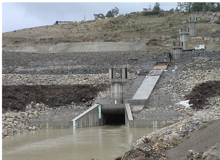
Εικόνα 1.1: Είσοδος σήραγγας εκτροπής.
