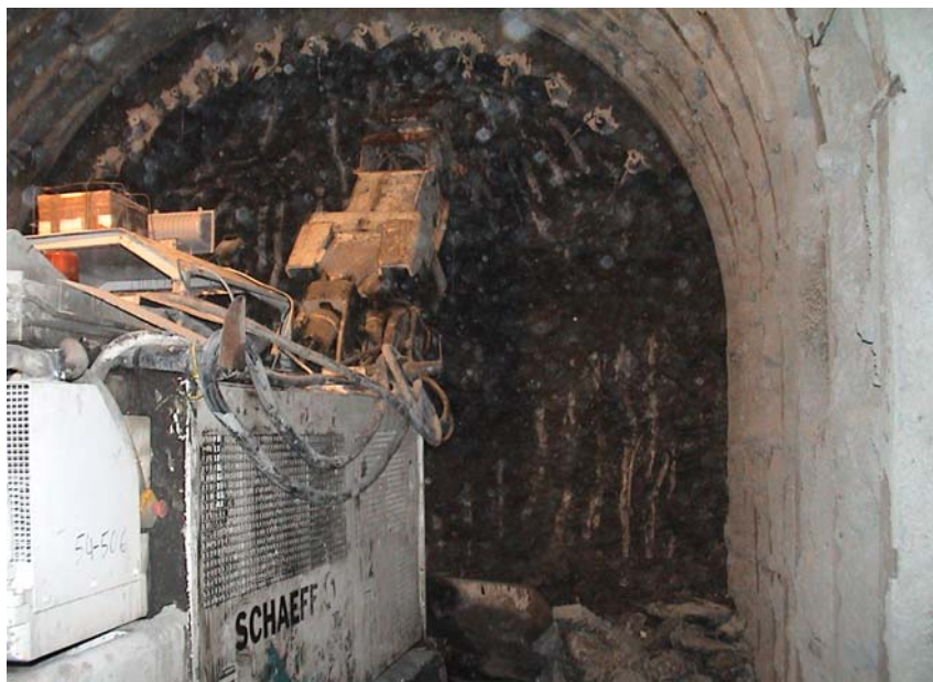
Εικόνα 1.2: Εκσκαφή σήραγγας εκτροπής (ΑΕΓΕΚ, 2001).
