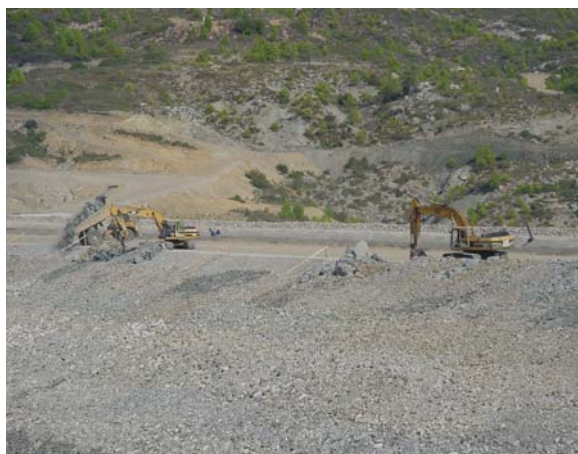
Εικόνα 1.8: Λιθορριπή προστασίας (ΑΕΓΕΚ, 2003).
