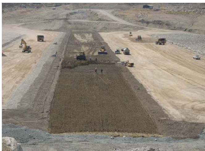
Εικόνα 1.7: Ζώνες φίλτρων – στραγγιστηρίων (ΑΕΓΕΚ, 2002).
