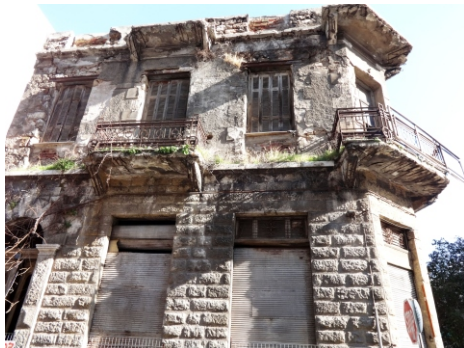
Εικ.79: Κτήριο στην Χατζηκυριάκου και Ηροδότου, στην Υδραϊκή συνοικία
