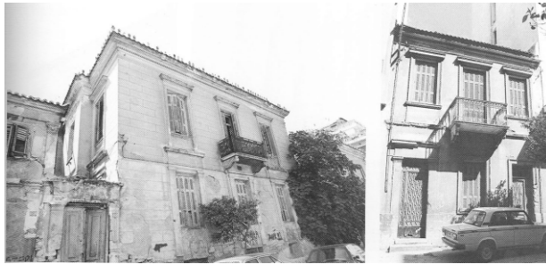
Εικ.23,24: Κατοικίες στην οδό Ευεργετών 16 και Ευποίας 5 αντίστοιχα
