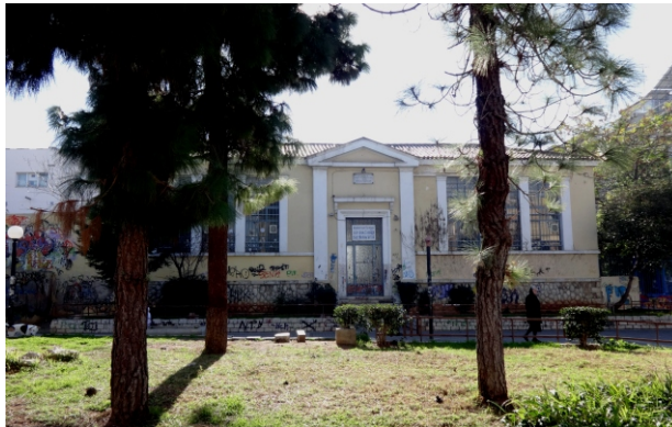
Εικ.26: Το σχολείο της Πλατείας Πηγάδας, όπως σώζεται σήμερα
