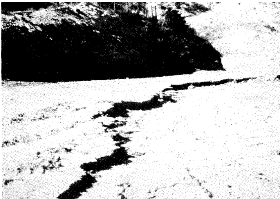
Σχήμα 2.2. Διαμήκης ρωγμή κοντά στα σύνορα με το φυσικό έδαφος η οποία εκδηλώθηκε μετά τον σεισμό του Northridge (1994) στο Χ.Υ.Τ.Α. Sunshine Canyon (Matasovic et al., 1998a).
