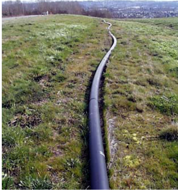
Σχήμα 2.5. Μετακίνηση των επιφανειακών αγωγών πολυαιθυλενίου του Χ.Υ.Τ.Α. Kent έπειτα από το σεισμό Nisqualli (Bray et al., 2001).
