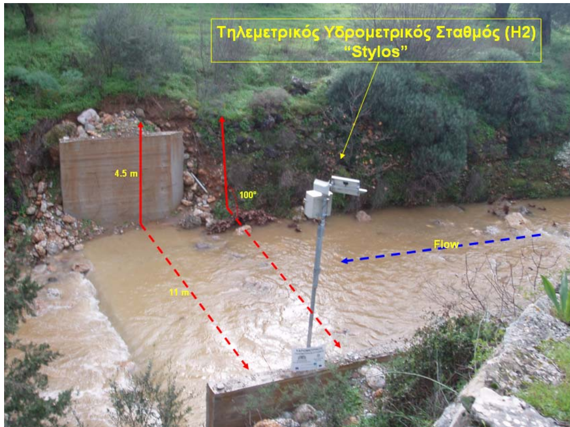
Εικόνα 2. 24. Τηλεμετρικός υδρομετρικός σταθμός Η2 (Στύλος) και τα κύρια γεωμετρικά χαρακτηριστικά της διατομής του.
