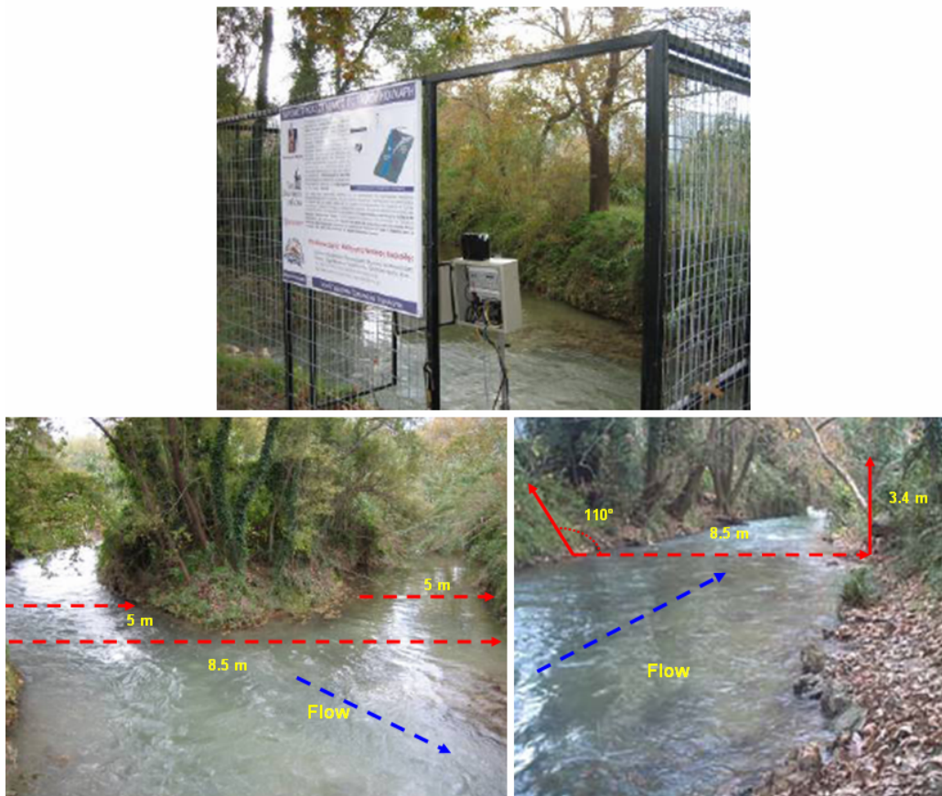
Εικόνα 2. 23. Τηλεμετρικός υδρομετρικός σταθμός H1 (Άγιος Γεώργιος) και τα κύρια γεωμετρικά χαρακτηριστικά της διατομής του ποταμού, [Σημείο ένωσης όλων των παραποτάμων της λεκάνης απορροής του Κοιλιάρη].
