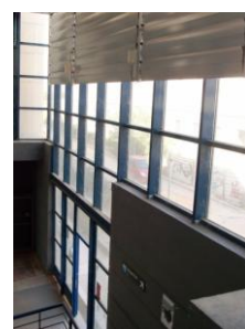
Εικόνα 4.5 Υαλοστάσιο με ηλιοπροστατευτικές περσίδες στην κεντρική ζώνη του κτηρίου.
