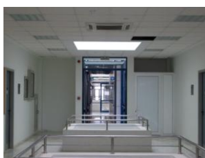
Εικόνα 4.4 Η οροφή του διαδρόμου διακόπτεται ανά διαστήματα από τετράγωνες οπές, μέσα από τις οποίες εισέρχεται φυσικό φως.
