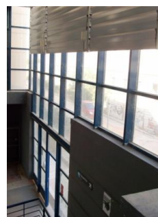
Εικόνα 7.17 Υαλοστάσιο με ηλιοπροστατευτικές περσίδες στην νότια πλευρά του χώρου της εισόδου του κτηρίου.
