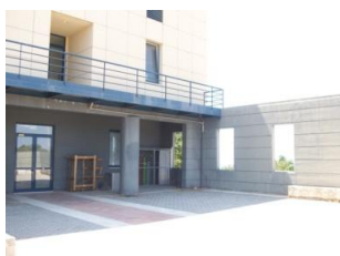
Εικόνα 7.6 Άμεσο εξωτερικό περιβάλλον του εργαστηρίου 2 (βορειο-ανατολική πρόσοψη).
