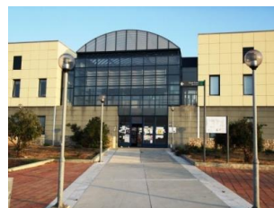
Εικόνα 7.16 Άμεσο εξωτερικό περιβάλλον του χώρου της εισόδου.
