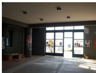
Εικόνα 7.15 Άποψη του υπό μελέτη χώρου, όπου φαίνεται η είσοδος με το βορειοδυτικό προσανατολισμό.
