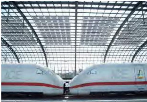
Εικόνα 22 Χρήση Φωτοβολταϊκών σε Κοινόχρηστους Χώρους
