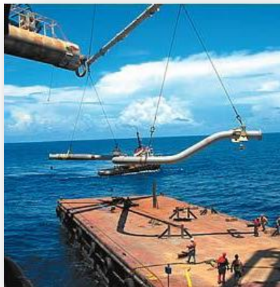
Εικόνα 1.9: Μεταφορά τμημάτων υποβρύχιου αγωγού (Πηγή: www.hellopro.uk ).
