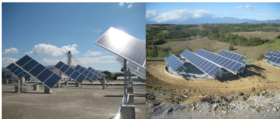
Εικόνα 3.7 Μονοαξονικά σύστημα παρακολούθησης (Α) οριζόντιου άξονα, (Β) κάθετου άξονα
