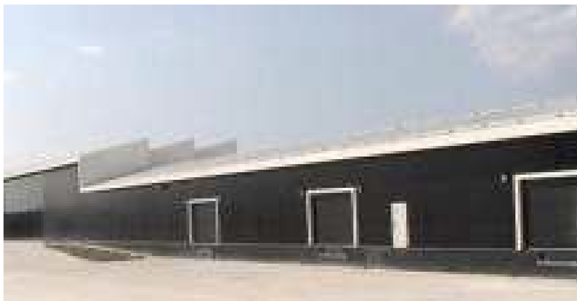
Εικόνα 4.17 Πρότυπο βιοκλιματικό κτήριο της ExelGroup
