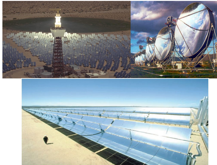
Εικόνα 2.18 Παραδείγματα τεχνολογιών CSPs α) Κεντρικός Πύργος β) Θερμική μηχανή γ) παραβολικά κάτοπτρα χιν
