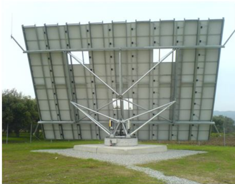
Εικόνα 3.9 Οπίσθια όψη διαζονικού συστήματος tracker (της εταιρίας MechatronABEE )
