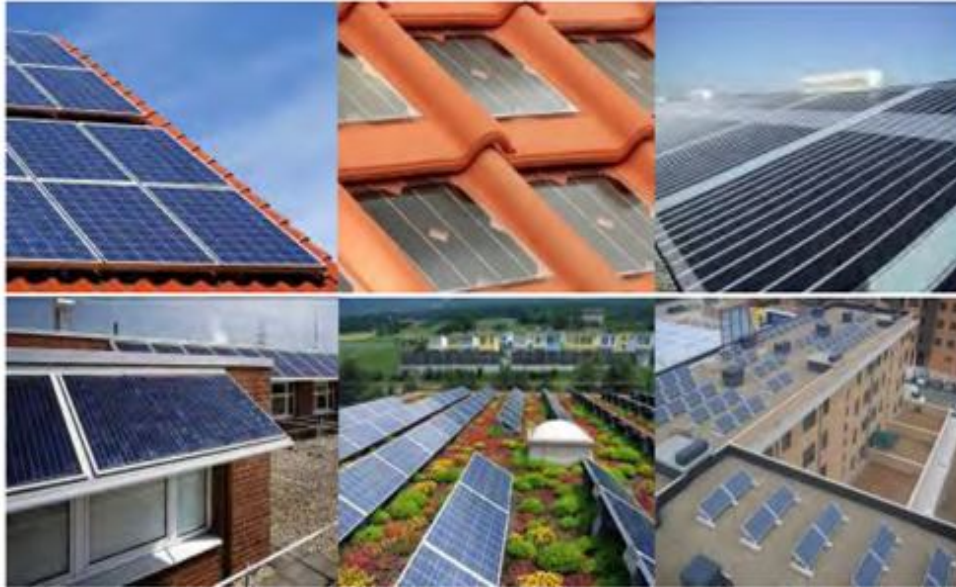
Εικόνα 3.5 Εγκατεστημένες Φ/Β συστοιχίες με σταθερή γωνία κλίσης
