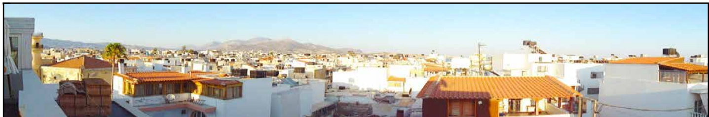
Πανοραμική άποψη της παλιάς πόλης με εμφανή τα σημάδια της αλλοίωσης της ταυτότητάς της
