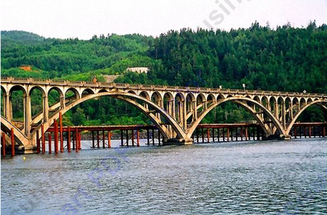
Εικόνα 2.5: Γέφυρα Rouge River με προεντεταμένο σκυρόδεμα [αναφορά].
