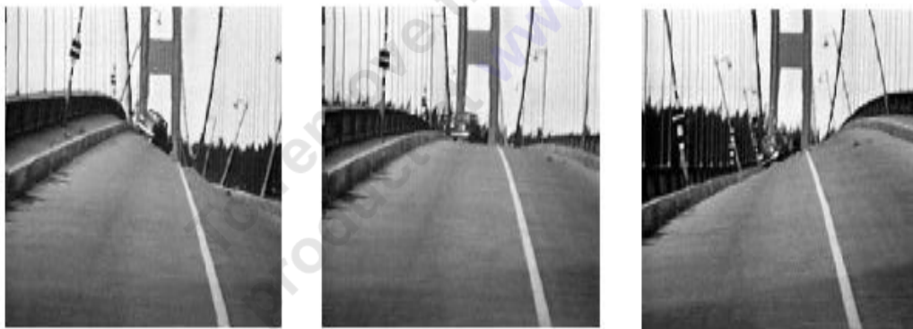
Εικόνα 3.12: Αστοχία της γέφυρας Tacoma Narrow λόγω στρεπτικών ροπών [αναφορά].
