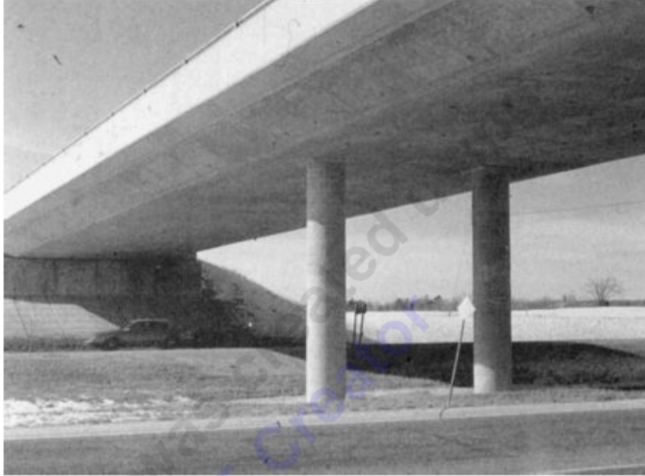
Εικόνα 2.7: Μορφή γέφυρας επιτόπιος χύτευσης [αναφορά].
