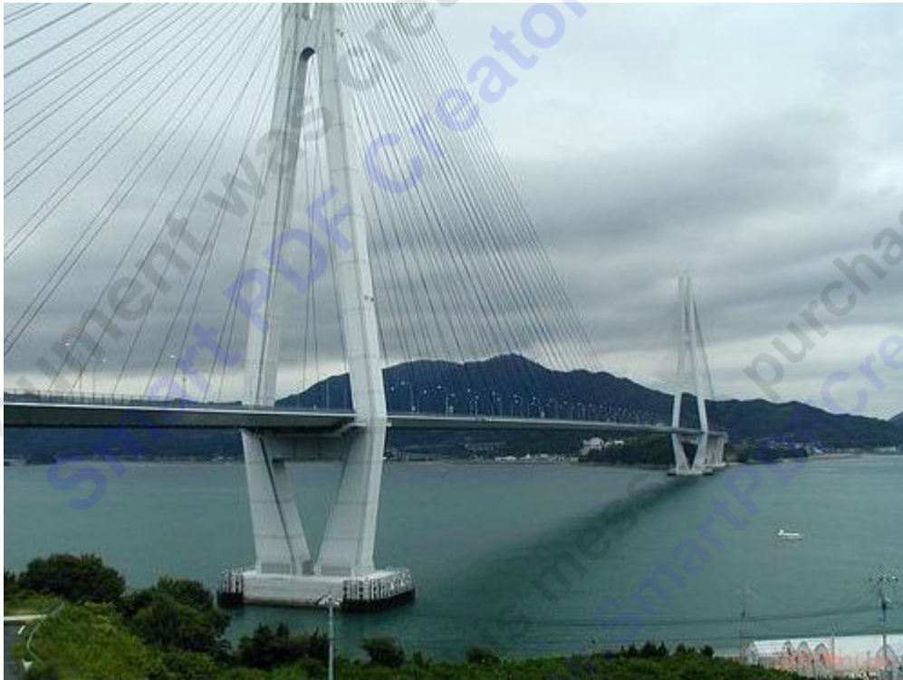
Εικόνα 1.2: Γέφυρα Tatara Bridge στην Ιαπωνία [αναφορά].
