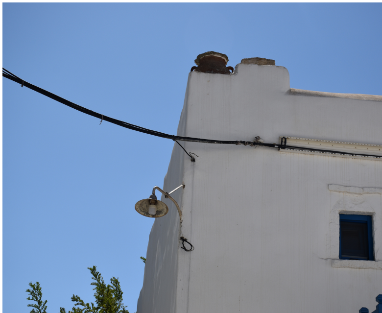
Εικόνα 74: Τυπική απόληξη τζακιού εντός των κατοικιών του Κάστρου
