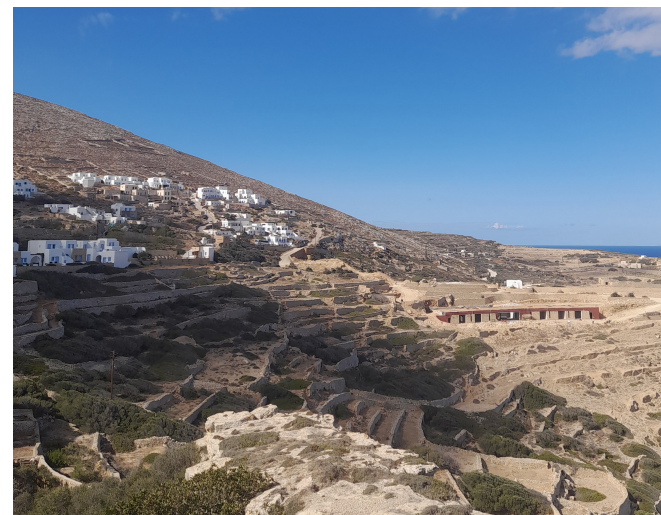
Εικόνα 73: Καινούρια κατασκευή υπόσκαφου καταλύματος
