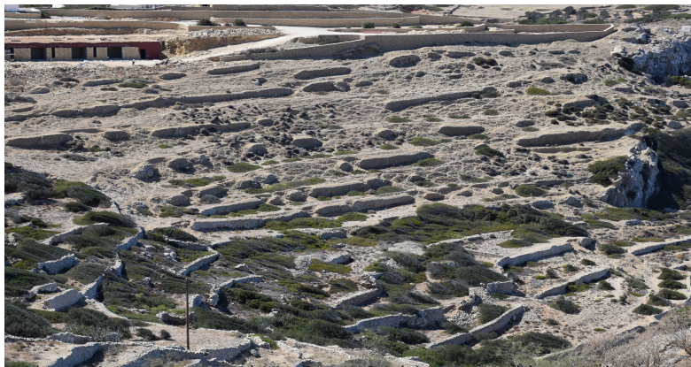
Εικόνα 83: Κατεστραμμένες ξερολιθιλιές σε πλαγιά στα όρια του οικισμού
