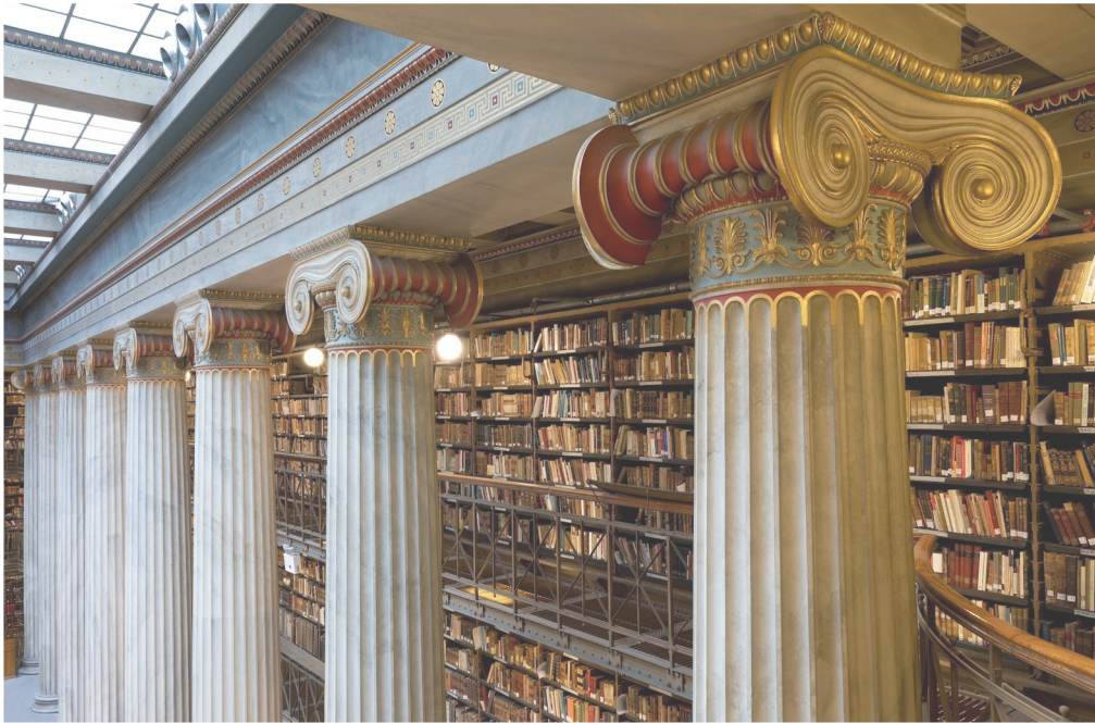
Εικ. 19. Άποψη της κεντρικής αίθουσας της Εθνικής Βιβλιοθήκης. Είναι ορατή η πολυχρωμία της ιωνικής κιονοστοιχίας, και η σχέση του χώρου με το φυσικό φως.
