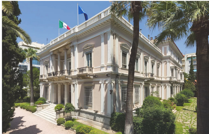
Εικ. 59. Το κτήριο διαρθρώνεται σε βάση, κορμό και στέψη. Στο μέσον κυριαρχεί το προστώο της εισόδου και ο εξώστης. Τα κιονόκρανα έχουν αναφορές σε αναγεννησιακά πρότυπα.
