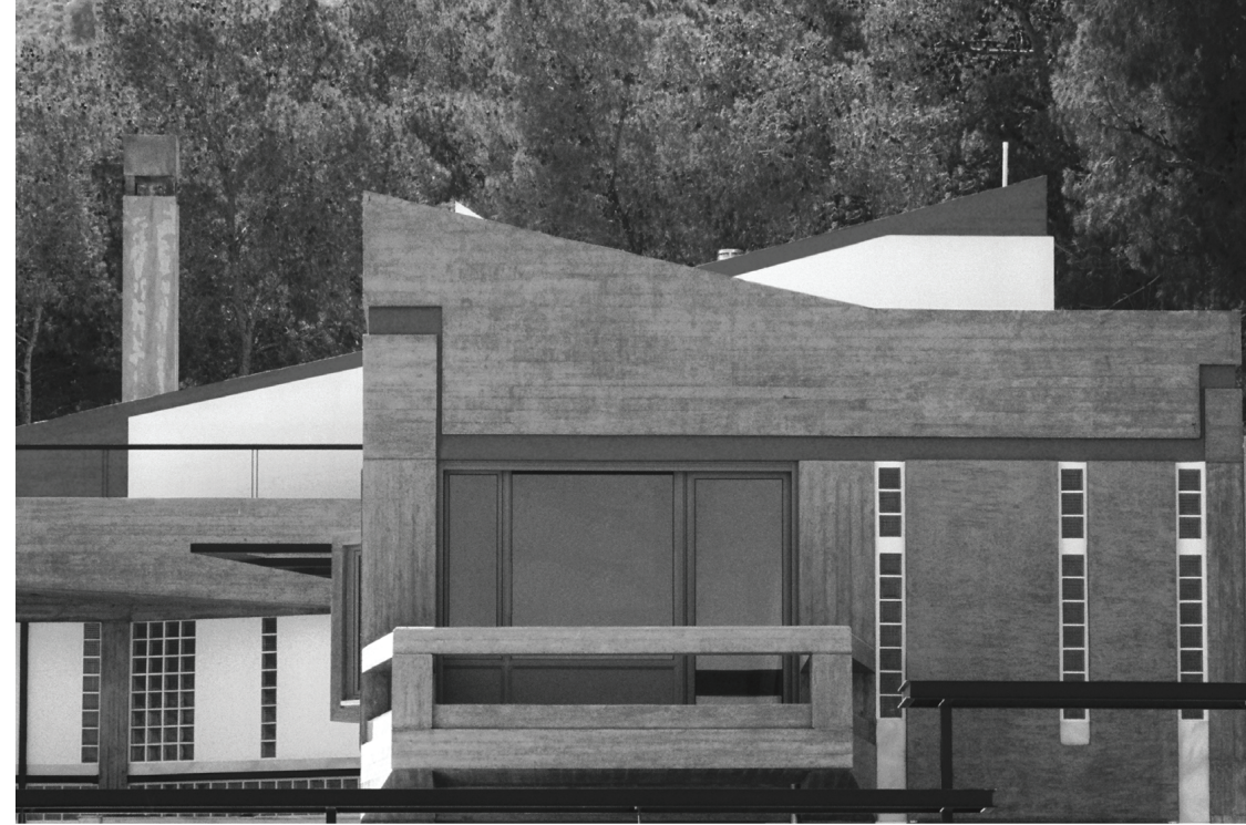
148 Βόρεια όψη. Πηγή: lifo.gr 149 Σκίτσο όψης. Πηγή: ό.π.
