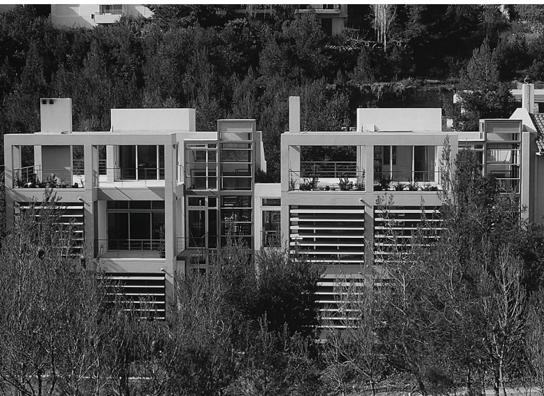
203 Διπλοκατοικία στην Κηφισιά. Πηγή: ktirio.gr
