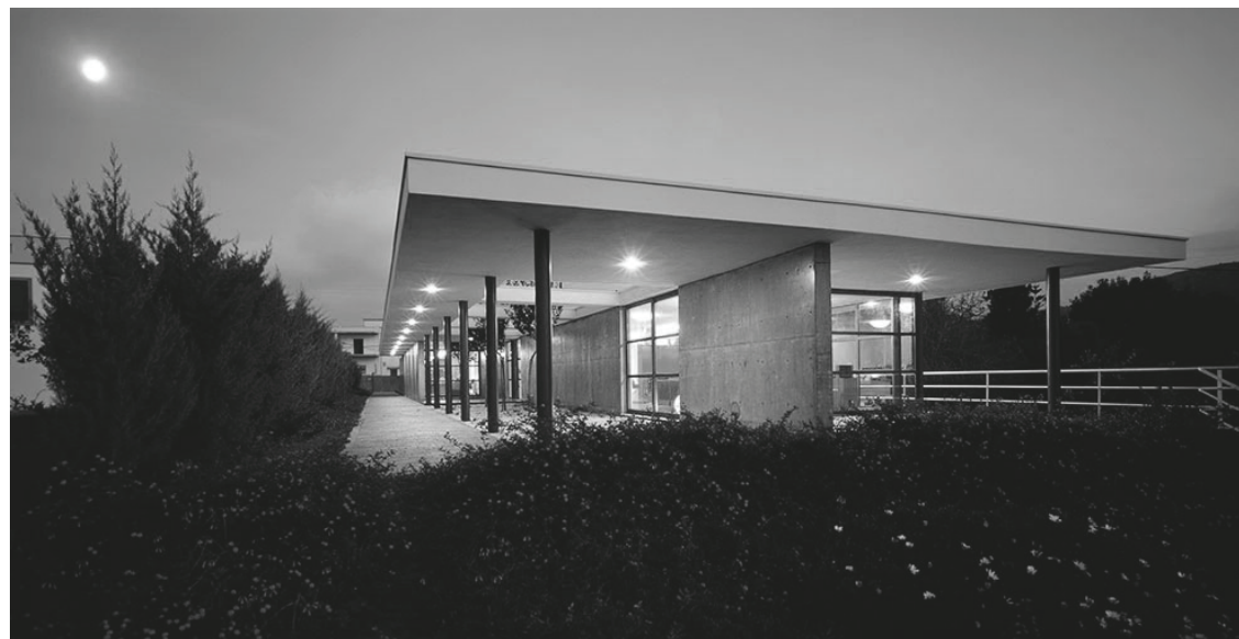
321 Γενική άποψη κατοικίας. Πηγή: ktirio.gr
