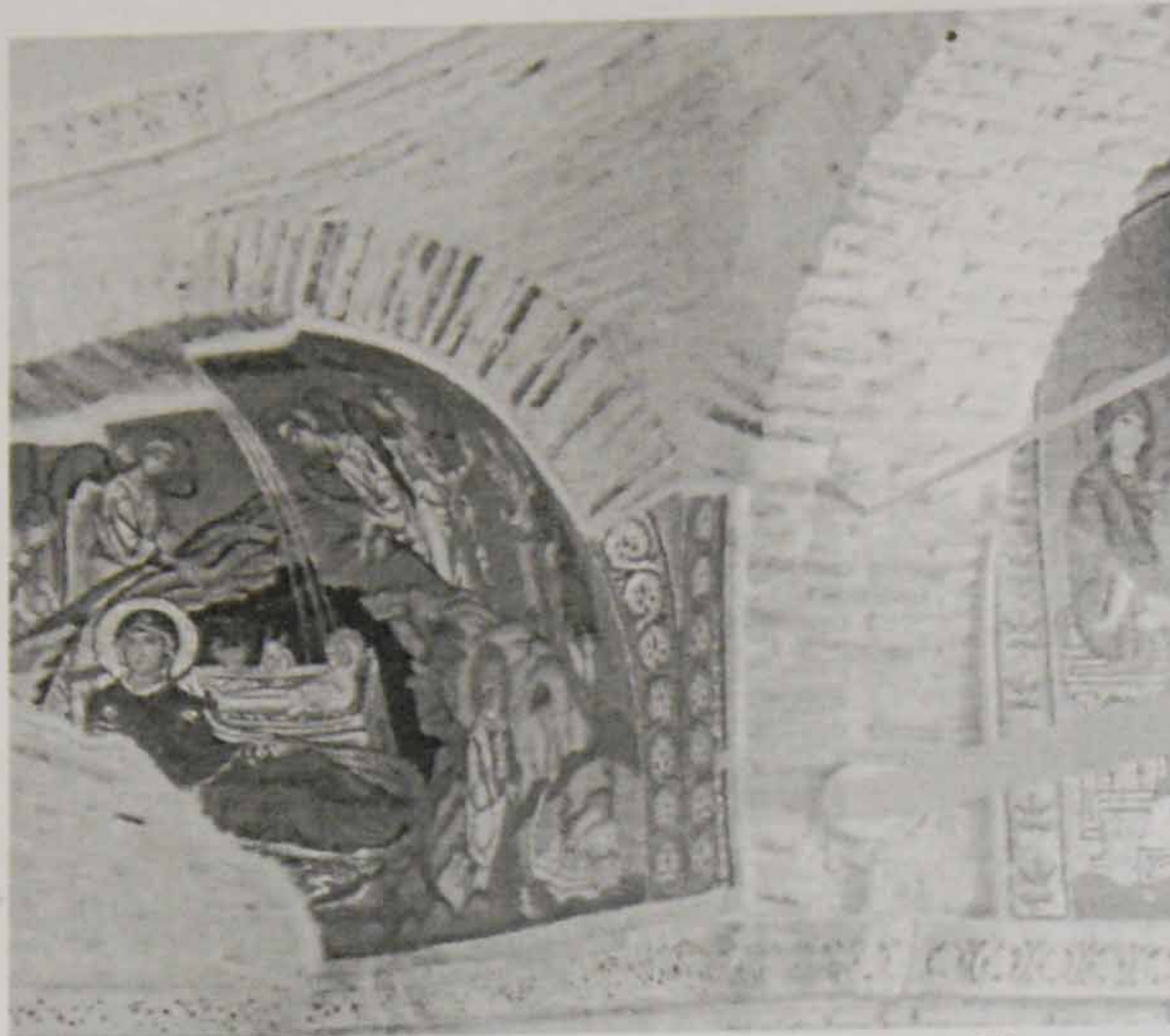
Εικόνα 8:ΝΑ ημιχώνιο, η παράσταση της «Γέννησης», ανάπτυξη υγρασίας στη Ν τμήμα της παράστασης στην τοιχοποιία
