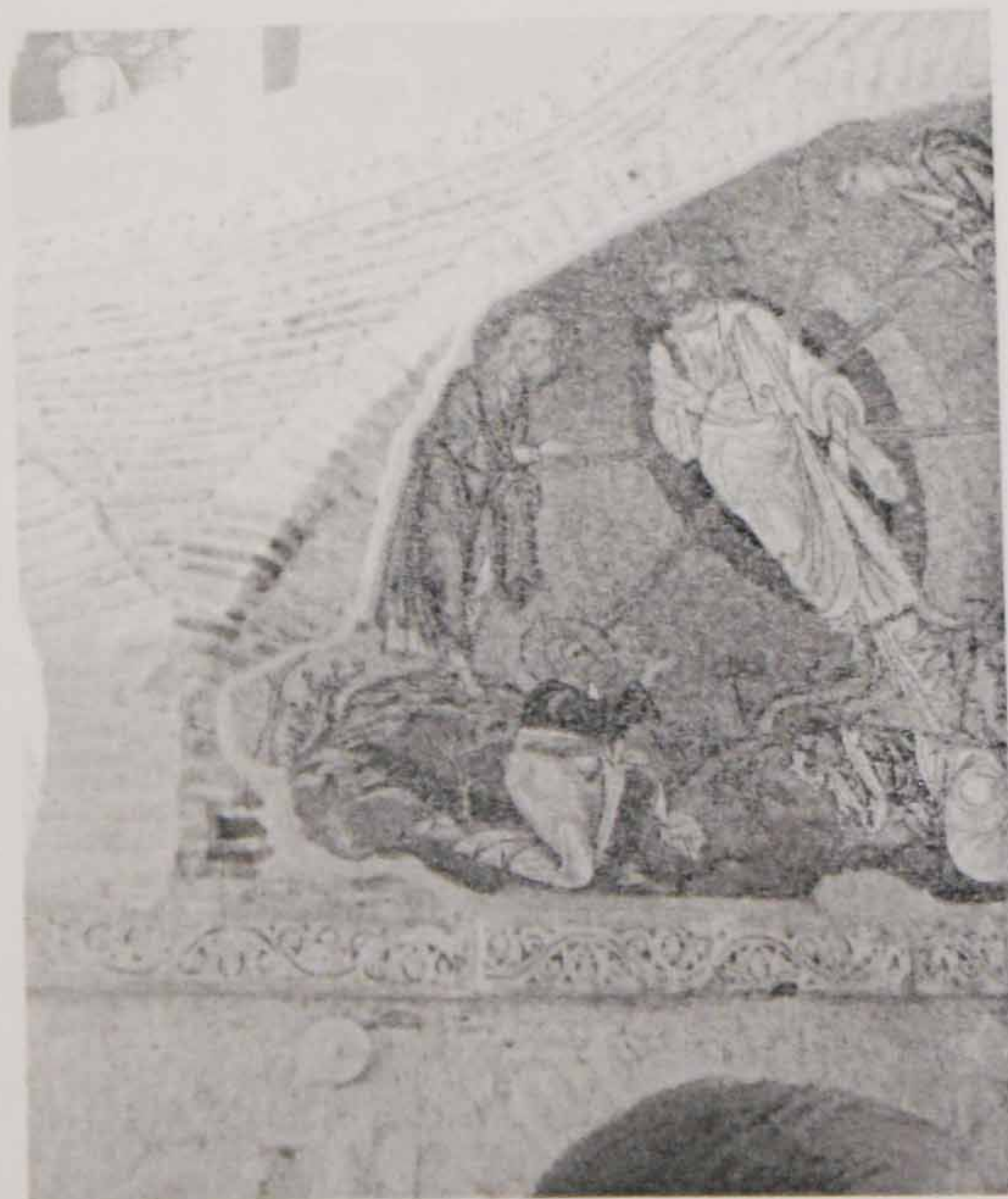
Εικόνα 7: ΒΔ ημιχώνιο, η παράσταση της «Μεταμόρφωση», ανάπτυξη υγρασίας στο ΝΔ τμήμα της παράστασης
