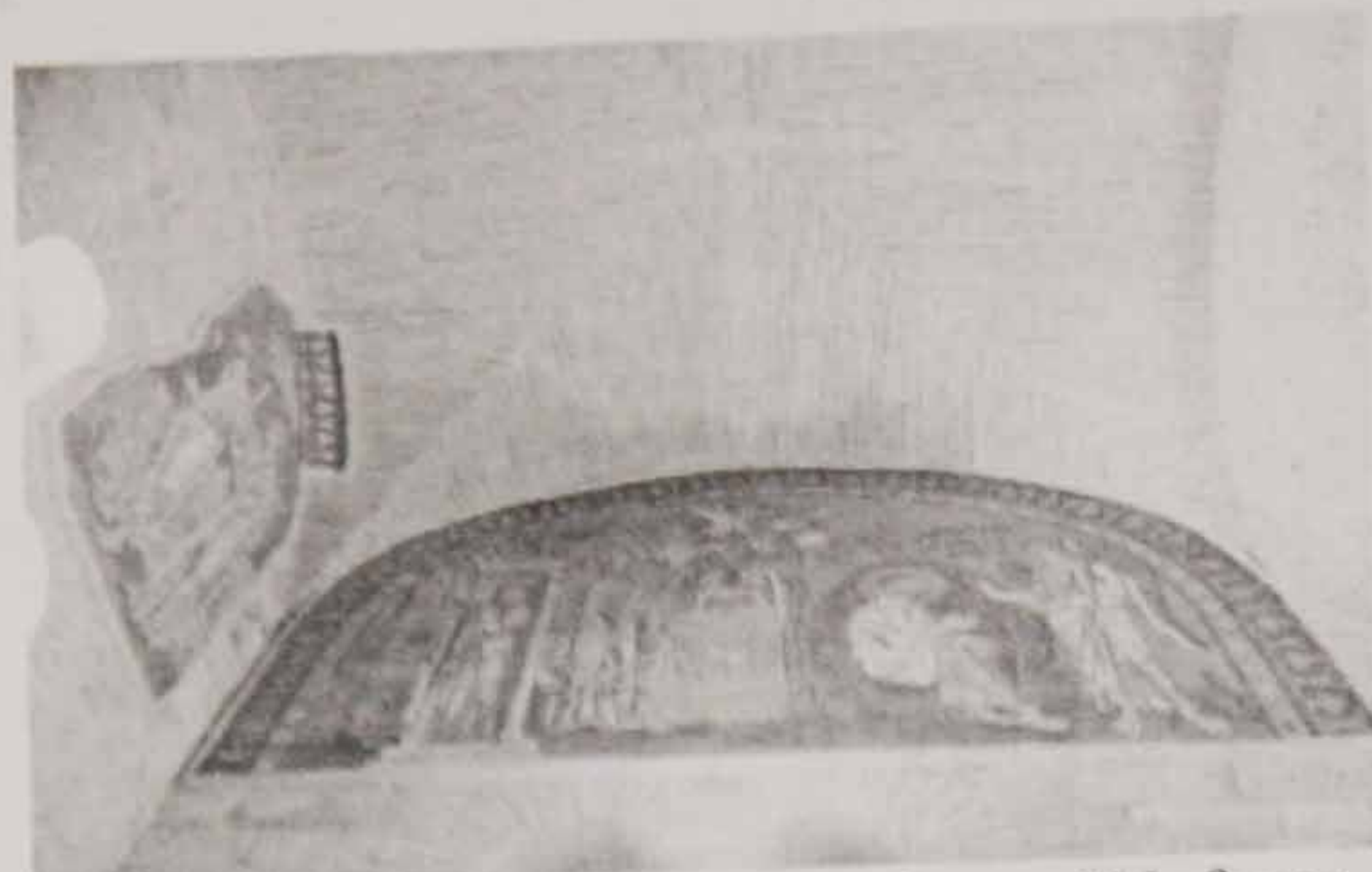
Εικόνα 6: Αποψη της ΝΔ πλευράς του Νάρθηκα, ανάπτυξη υγρασίας στη γένεση του σταυροθολίου
