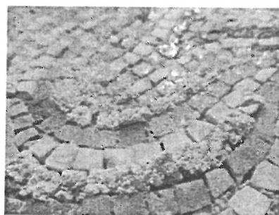
Λευκή πούδρα στην τοιχοποιία του Νάρθηκα και εξανθήσεις σε σαθροποιημένεμες ψηφίδες στο πρόσωπο του Αγ. Αβερκίου
