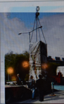
Διαδικασία μεταφοράς αρχιτεκτονικού μέλους. Εργοστάσιο Ευαγγελισμού.
