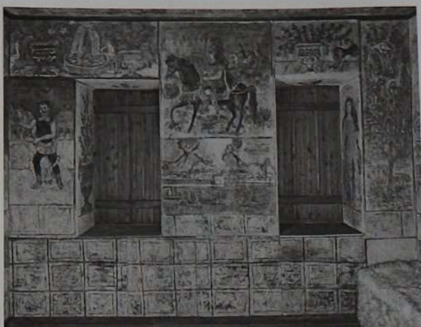
Γενική άποψη δυτικού τοίχου.
