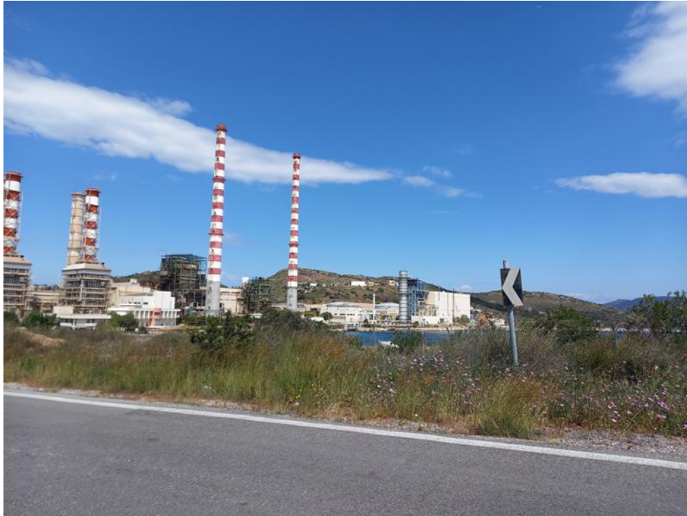
Εικόνα 6. Ατμοηλεκτρικό εργοστάσιο παραγωγής ηλεκτρικής ενέργειας Κερατέας-Λαυρίου.
