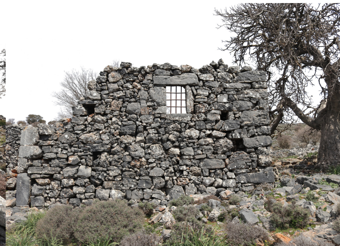
Εικόνα 75. Το κτίσμα [B2], το οποίο είναι ένα κλασικό πλατυμέτωπο κτίριο, διατηρεί ακόμα τις σιδερέες στα ανοίγματά του.
