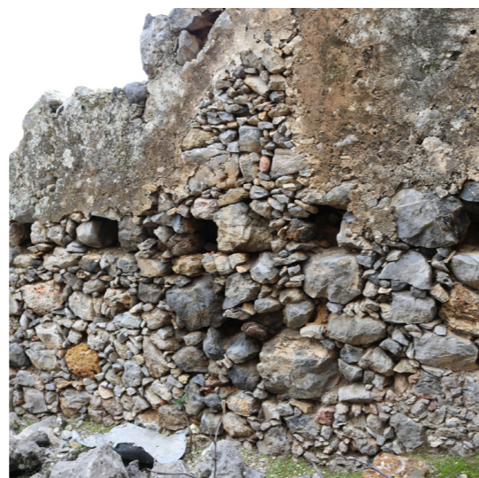
Εικόνα 125. Παλιό επίχρισμα στο εσωτερικό κτίσματος στο Γεωργίτσι, πιθανώς στενομέτωπο με διπλό ύψος, αφού έχουν μείνει ίχνη από τους θύλακες των δοκαριών.
