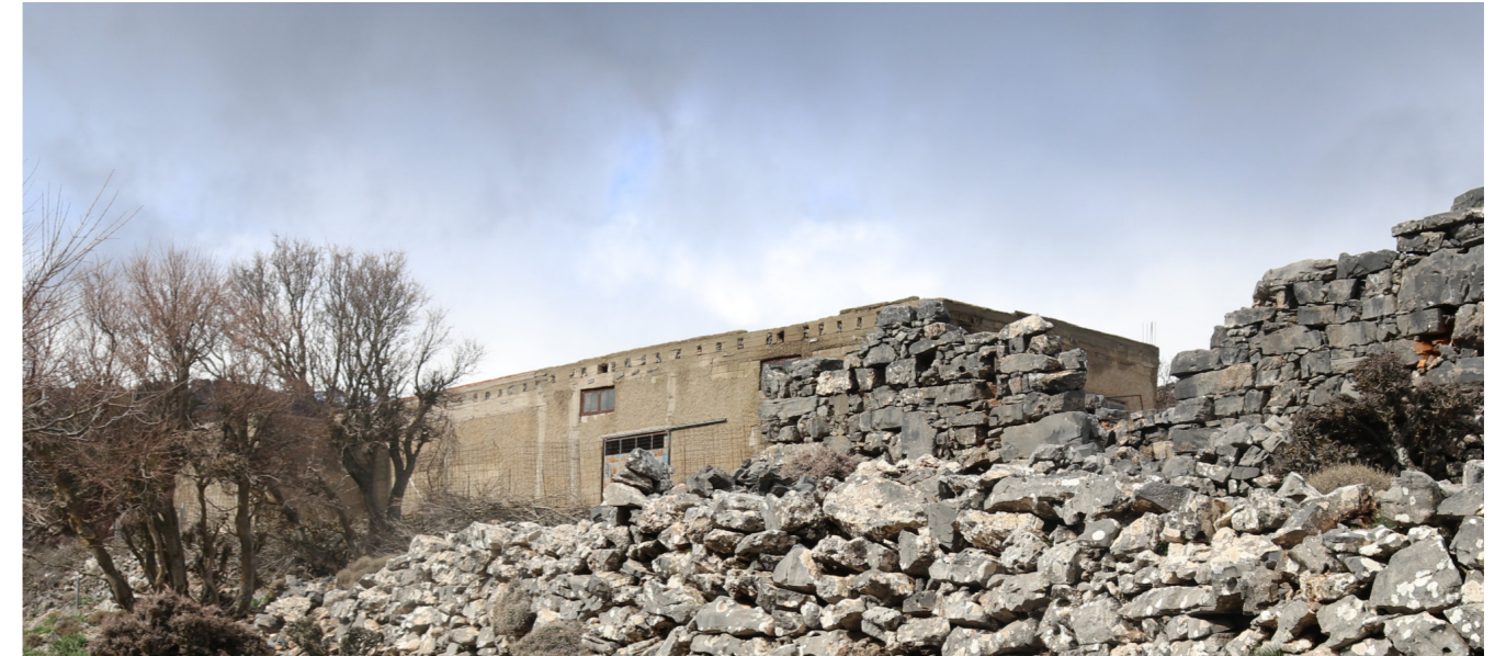
Εικόνα 164. Το κτίσμα στην είσοδο του Χωριού, περιοχή Πατελούρα.
