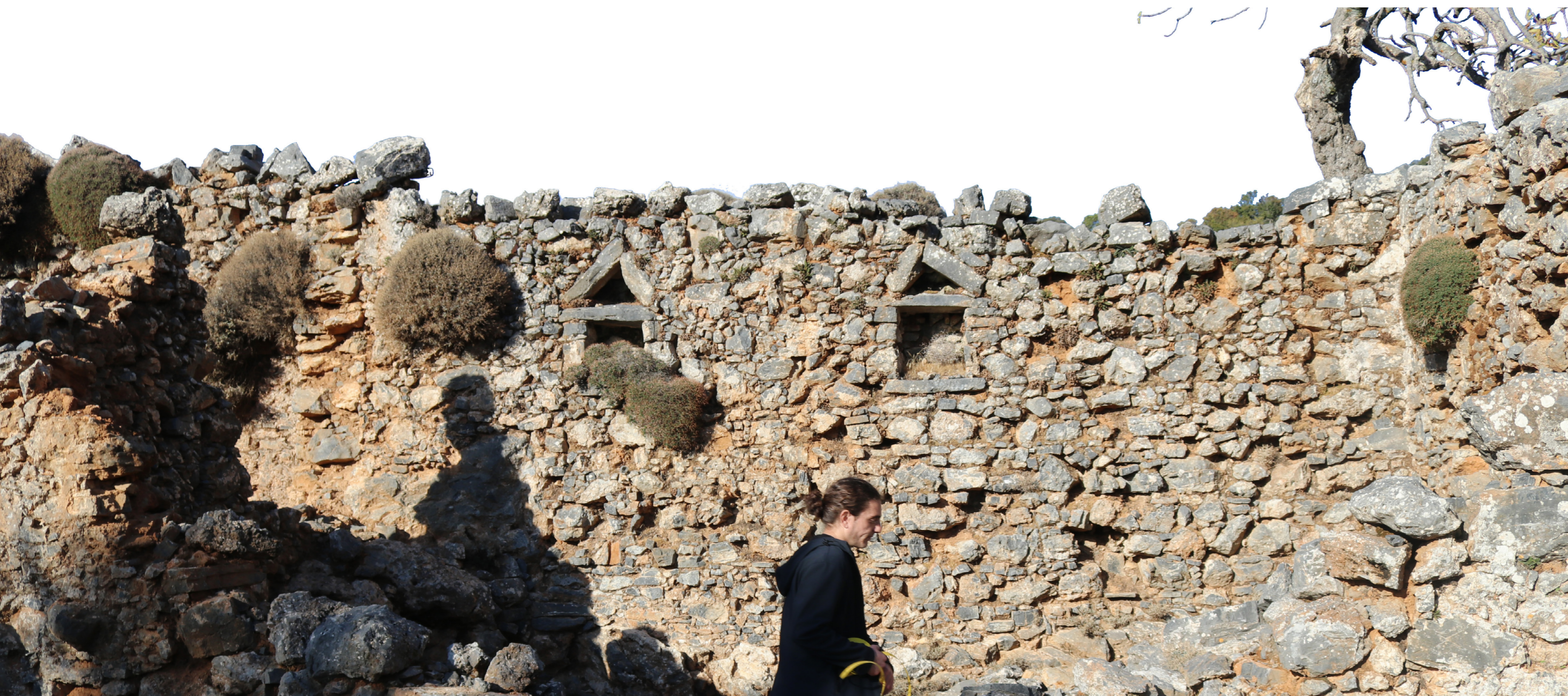
Εικόνα 125. Παλιό επίχρισμα στο εσωτερικό κτίσματος στο Γεωργίτσι, πιθανώς στενομέτωπο με διπλό ύψος, αφού έχουν μείνει ίχνη από τους θύλακες των δοκαριών.
