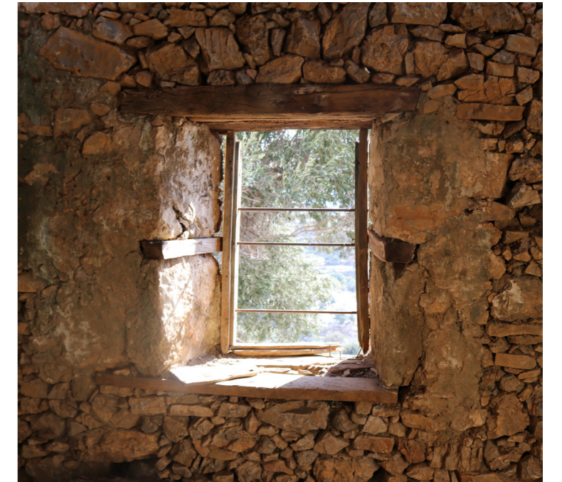
Εικόνα 139. Παράθυρο με εγκάρσιο ξύλο για την στήριξη της κάσας. Πωργίτσι.
