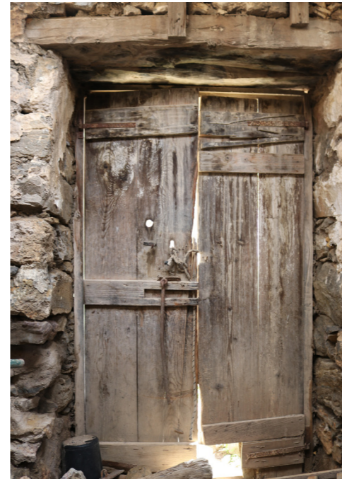
Εικόνα 138. Σκούρο στο Πωργίτσι, με κόντε μηρί και σύρτη.
