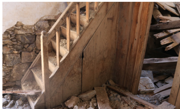
Εικόνα 144. Ξύλινη σκάλα με αποθηκευτικό ντουλάπι.
