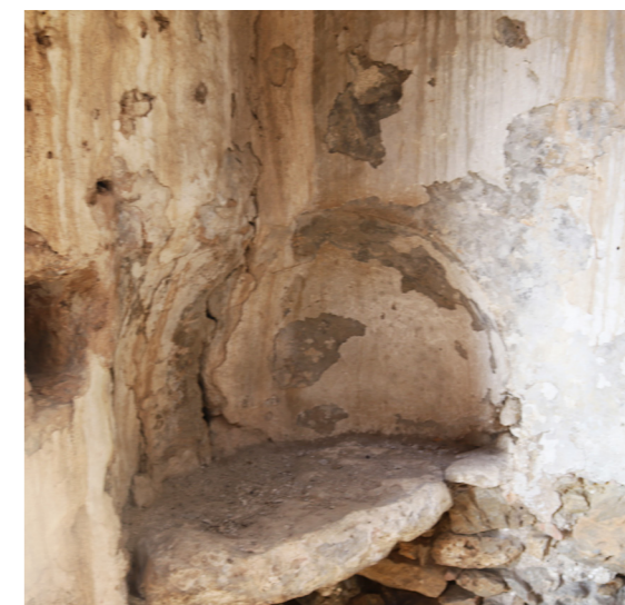
Εικόνα 128. Χώρος τοποθέτησης στάμνας σε τοιχοποιία στο Γεωργίτσι.
