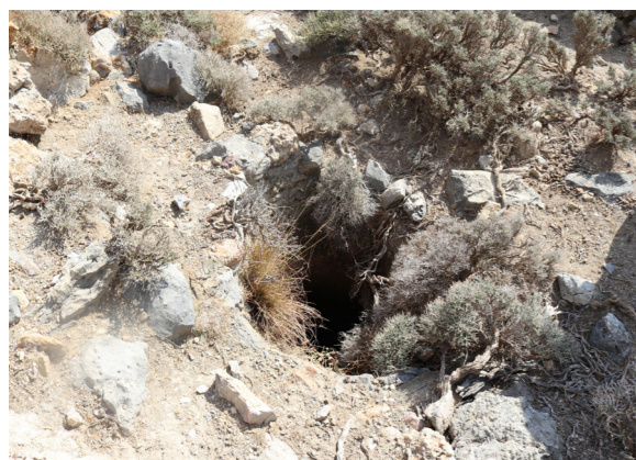
Εικόνα 31. Ένταφιασμένη στέρνα δίπλα σε κατοικία στο Γιωργίτσι
