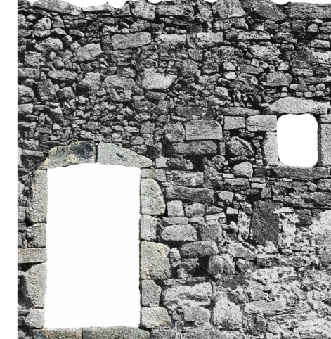
Εικόνα 132. Πόρτα και παράθυρο σε κατοικία στο Μουρί με λαξευτούς λίθους (πελέκια).
