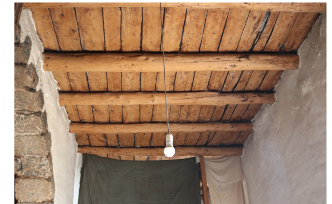
Εικόνα 156. Παραδοσιακή ξύλινη οροφή σε κατοικία στο Μουρί, κατασκευασμένη από χοντρά δοκάρια και σανίδες.
