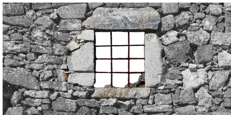
Εικόνα 129. Παράθυρο σε κατοικία στο Μουρί, τα πελέκια και οι μεταλλικές σιδεριές αποτελούν κύριο χαρακτηριστικό του οικισμού.
