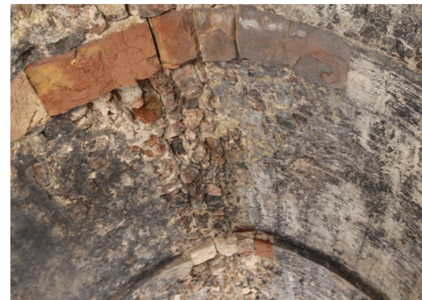
Εικόνα 152. Ημίξεστοι θολίτες στην εκκλησία του Χριστού στο Γιωργίτσι. Οι λίθοι της καμάρας φαίνεται ότι δεν προέρχονται από τοπικά πετρώματα, αλλά πιθανώς από άλλο μέρος, υποδηλώνοντας διαφορετική προέλευση και πιθανές μεταφορές υλικών.
