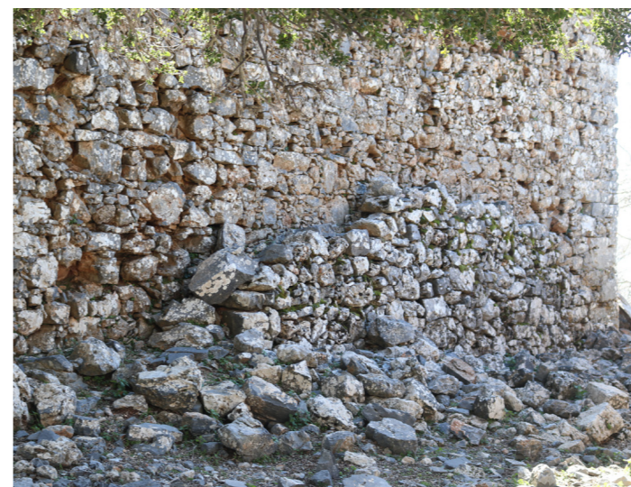
Εικόνα 127. Διπλός τοίχος αντιστηριζής σε κατοικία στο Μουρί.
