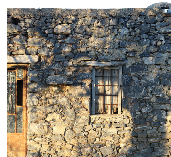
Εικόνα 157. Δώμα από μεπτόν και προσθήκη νέας υδρορροής
