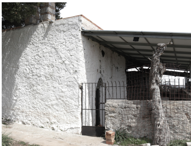
Εικόνα 162. Η Δυτική όψη του ναού μετά τις επεμβάσεις.
