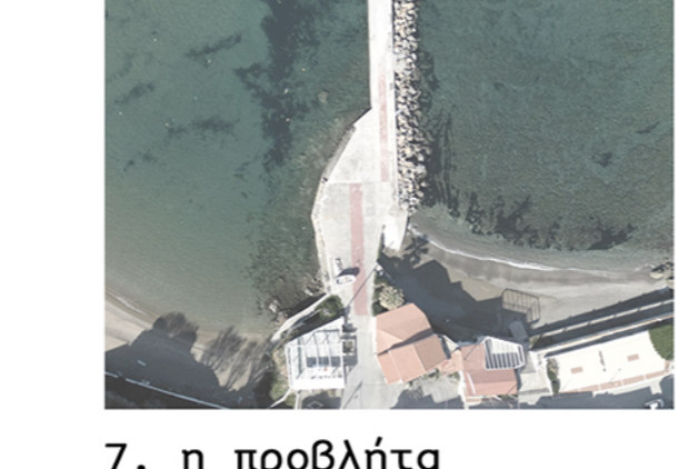
7. η προβλήτα αφαίρεση ευτελών κατασκευών
