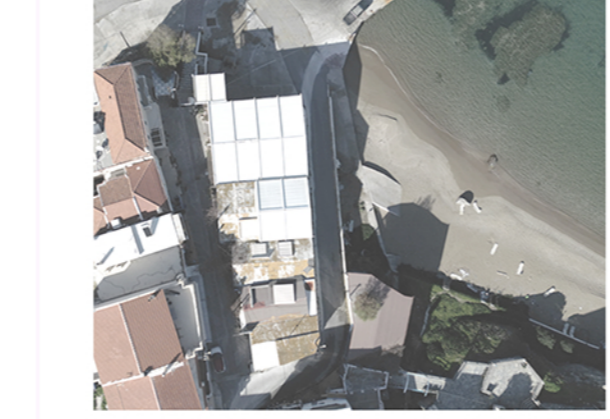
4. οάλα αφαίρεση ευτελών κατασκευών
