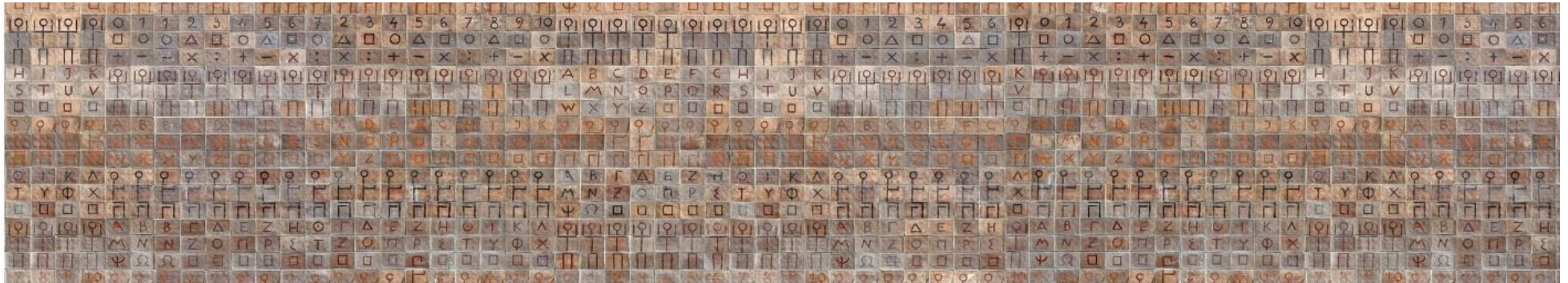
Εικόνα 33: Επιτοίχια σύνθεση στην πρόσοψη της σχολής Μωραΐτη- Ψυχικό
