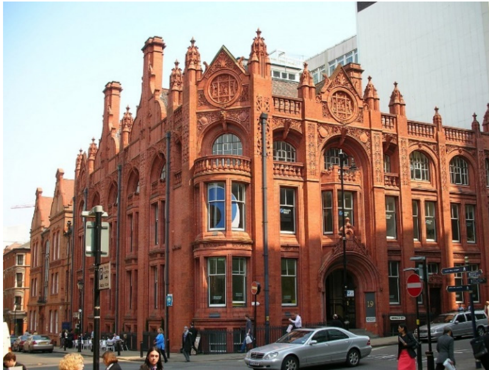
Εικόνα 1: Bell Edison Telephone Building στο Μπέρμιγχαμ, ένα κτίριο από κόκκινο τούβλο και αρχιτεκτονική τερακότα του τέλους του 19ου αιώνα
